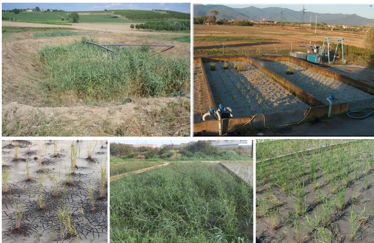
**Figura 43 -** Impianti di fitodisidratazione realizzati in Italia (Fonti: Iridra, CNR/Acque Spa)
